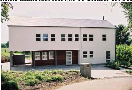
Piétrebais. Un exemple intéressant de bâtiment contemporain, qui malgré certains choix dénotant d'une esthétique actuelle, s'intègre très bien dans le paysage villageois : mode d'implantation, gabarit général, relative simplicité typo-morphologique (pas de lucarne néo-rustique, pas de toiture débordante,...).
