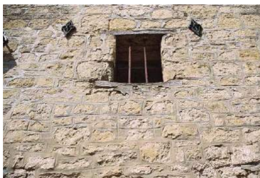
Lincient (hors canton de Jodoigne). Détail d'un bâtiment en tuffeau de Lincient : une roche à la teinte plus jaune et moins laiteuse que la Gobertange.
