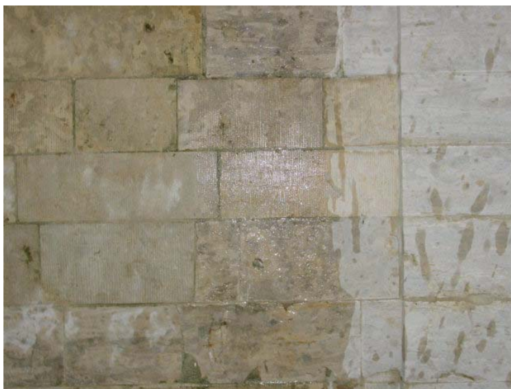
Mélin. Détail de l'appareil du mur de l'église en pierre de Gobertange.
