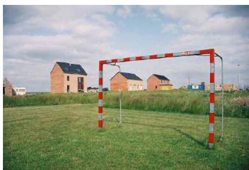
Hélécine. Vue sur les extensions d'habitat de Hampteau. Succession lâche et peu homogène de volumes autonomes ainsi de gabarits trop différenciés et peu conformes à la silhouette du bâti traditionnel. Au centre, une maison visiblement trop verticale.
