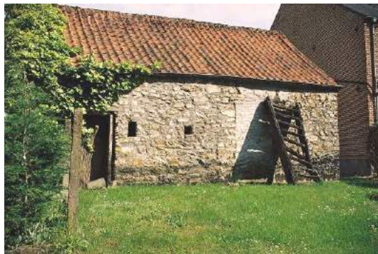
Dongelberg, le long de la N222, au sud du village. Petit bâtiment qui constitue un exemple parmi d'autres du bâti édifié en pierre (quartzite) provenant de la carrière toute proche. Dans le village de Dongelberg, mais aussi dans les villages de Jodoigne-Souveraine, Jauchette, Glimes et Ramillies, plusieurs bâtiments ont été construits à l'aide de ce matériau donnant au bâti une physionomie particulière et distincte de celle des villages "blancs" comme Mélin et Saint-Rémy-Geest.
