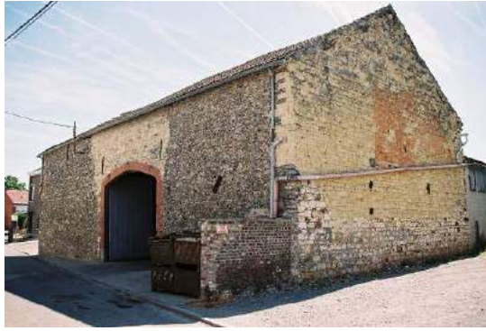
Orp-le-Grand, près de la place centrale. Une belle grange partiellement en silex et en tuffeau.
