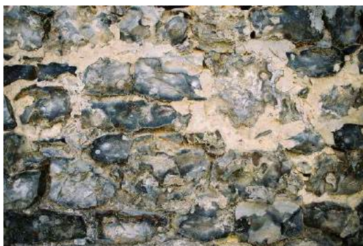
Orp-le-Grand. Près de la place centrale. Grange, détail de la maçonnerie en silex.
