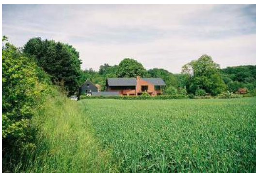
Piétrebais Une maison contemporaine relativement bien dissimulée dans la végétation. Sous une bâtière assez traditionnelle qui évoque certains hangars agricoles ouverts, le volume s'articule avec une liberté peu courante en milieu rural. La brique, trop rouge, aurait pu être peinte (blanc?).
